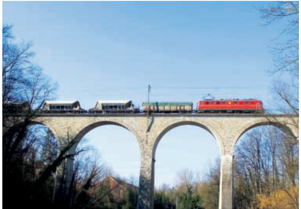
Transport fast ausschliesslich mit der Bahn – wie hier auf dem Rheinviadukt bei Eglisau.
