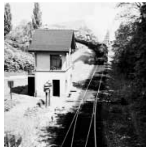
Dampfbetrieb noch bis 1956: Basler Rheinbrücke.
