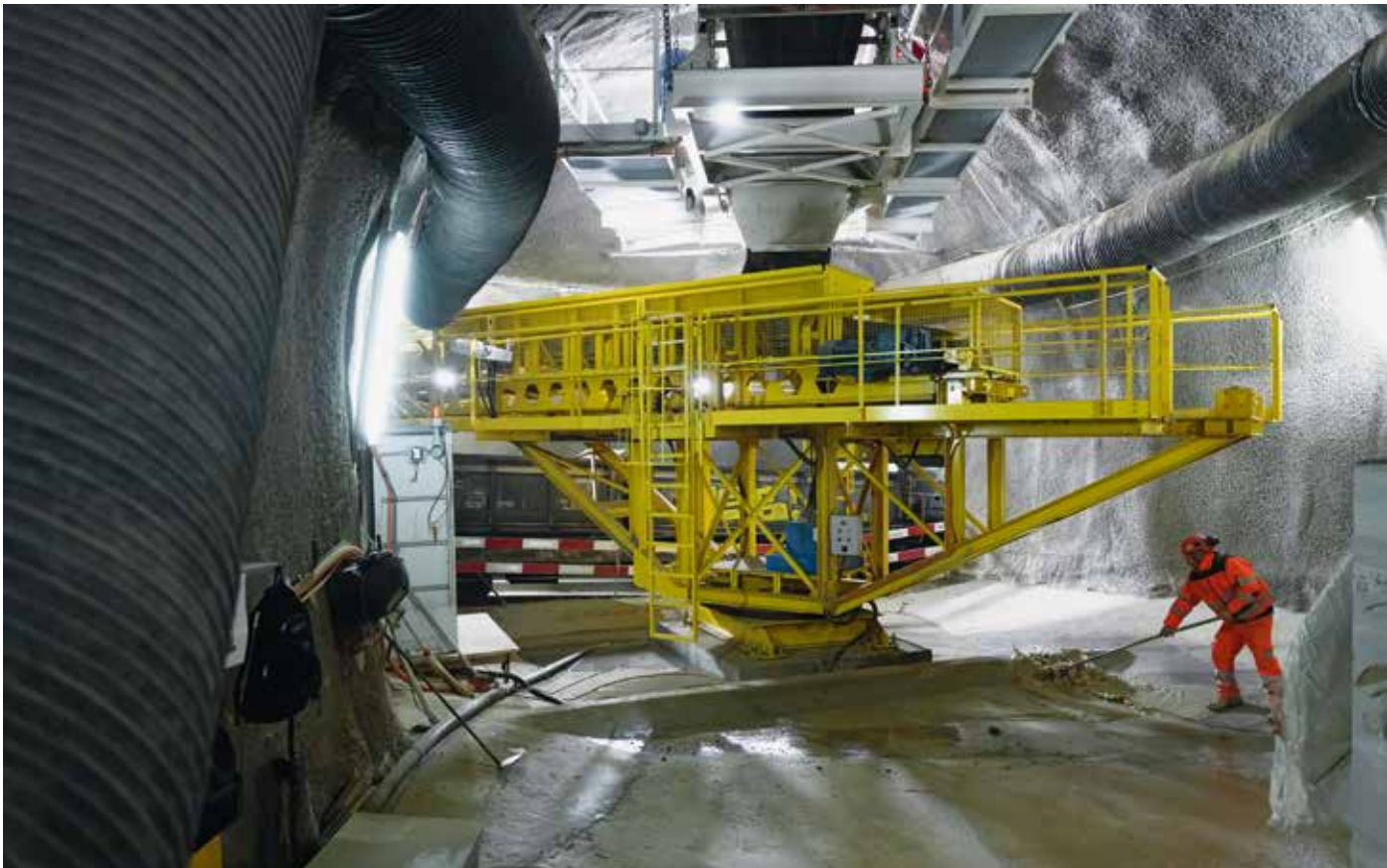
Für den Abtransport des Ausbruchmaterials per Zug wurden enorme Anlagen installiert.
