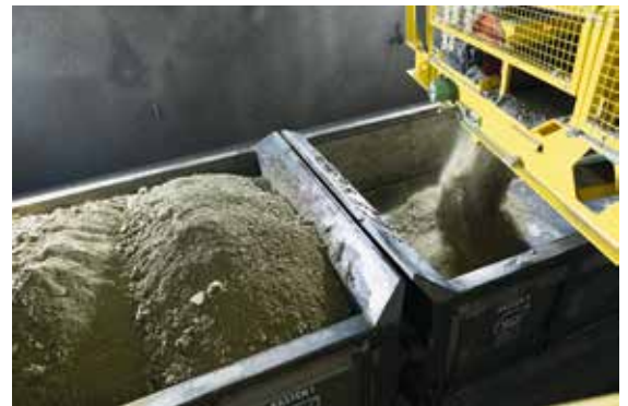
Die Ladung besteht grösstenteils aus Erde. Das Gestein wurde bereits abtransportiert.
