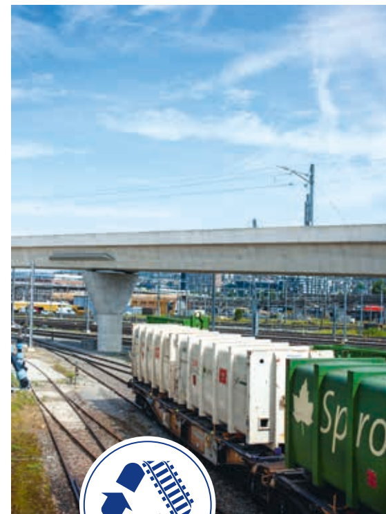
Von der Entsorgungsstelle direkt aufs Gleis, und das mitten in Zürich.
