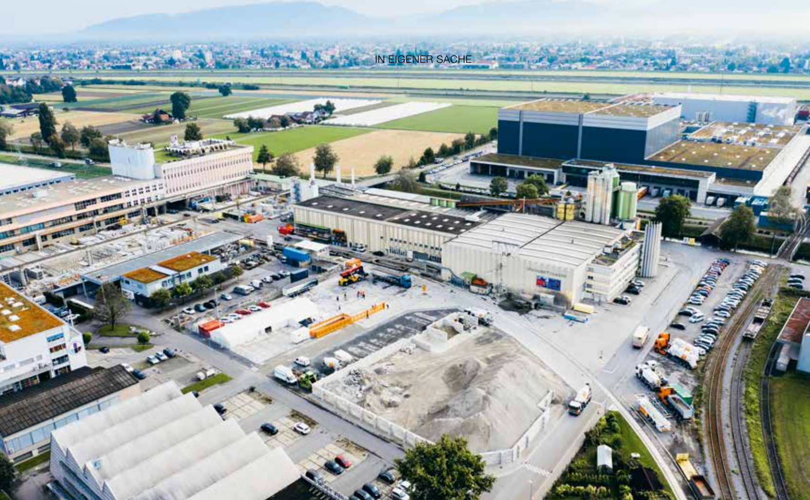
Das 3000 Quadratmeter grosse Firmenareal der saw gruppe hat einen eigenen Bahnanschluss.
