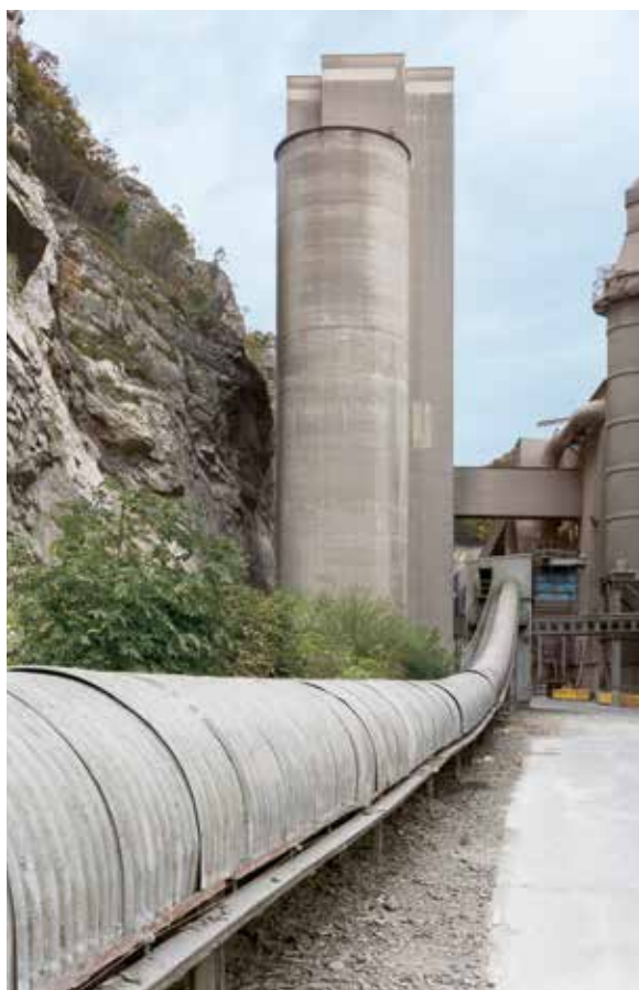
Système de convoyage de la carrière La Tscharner à la cimenterie
