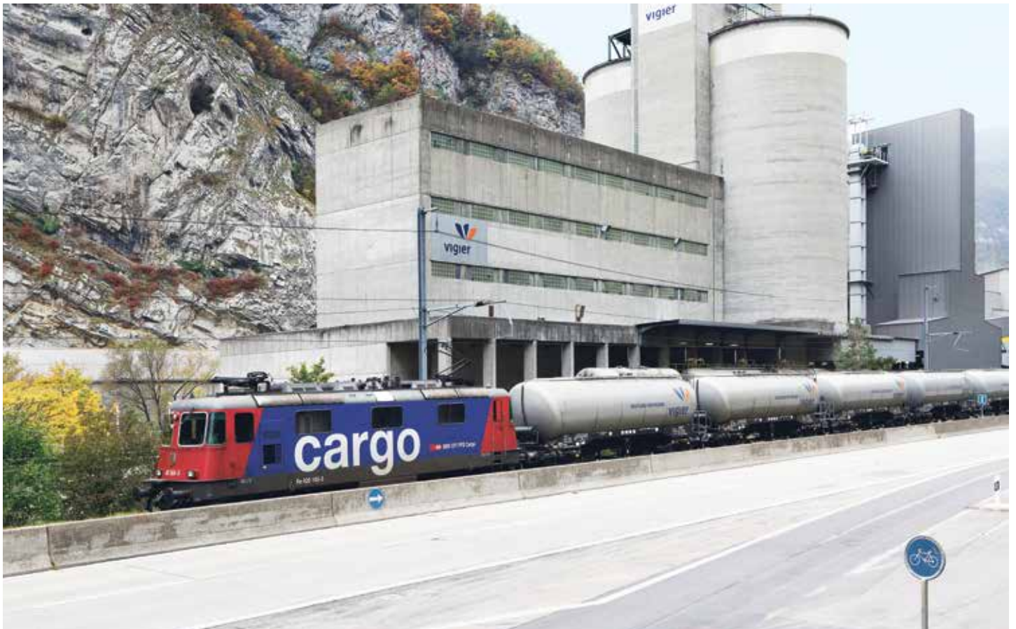
Vigier Ciment mise sur le rail pour promouvoir la durabilité.
