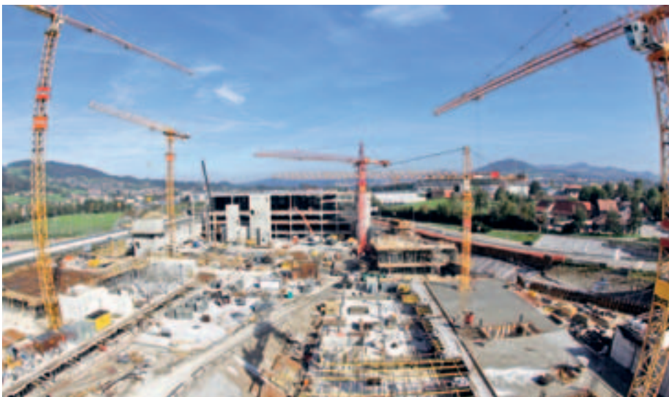
Le chantier du stade de Saint-Gall: une des destinations finales du ciment du Jura.
