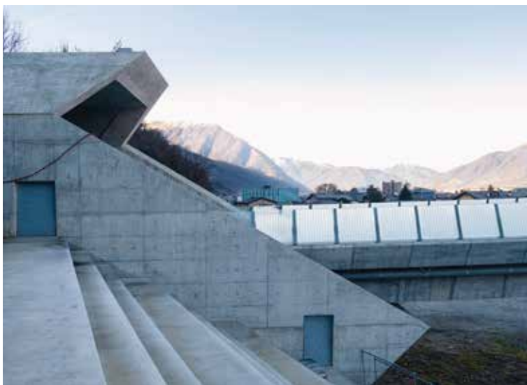
Le Portail nord Vigana du nouveau tunnel de base du Ceneri est un véritable point de mire.
