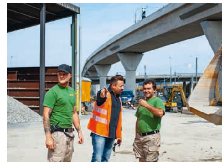
Photo du haut: Josef Binzegger (au centre), responsable de l'élimination chez Spross Debag AG à Zurich, connaît le centre d'élimination comme sa poche. Photo du bas: Vue du centre d'élimination avec le gratte-ciel de la Prime Tower en arrière-plan.
