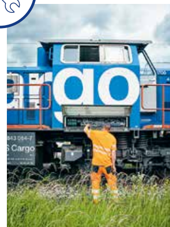
Quelques manœuvres plus tard, le nouveau calculateur est installé.
