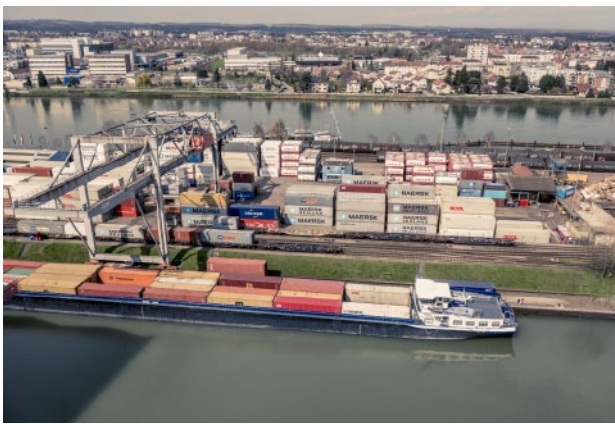
Asse nord-sud: un viaggio attraverso la Svizzera.
