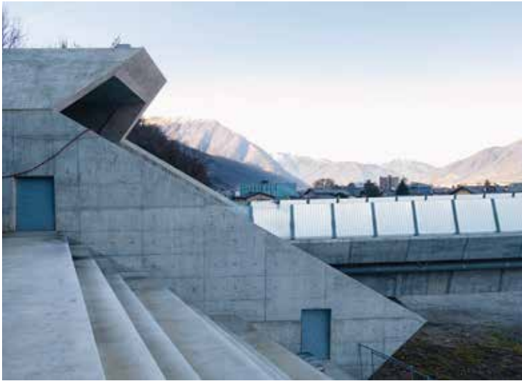
Il portale nord Viganà della nuova galleria di base del Monte Ceneri rapisce l'occhio.
