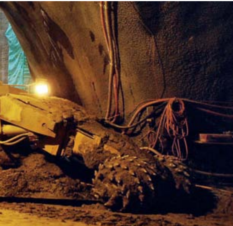
Die Bagger graben unter dem Hauptbahnhof Zürich einen neuen Verkehrsweg.
