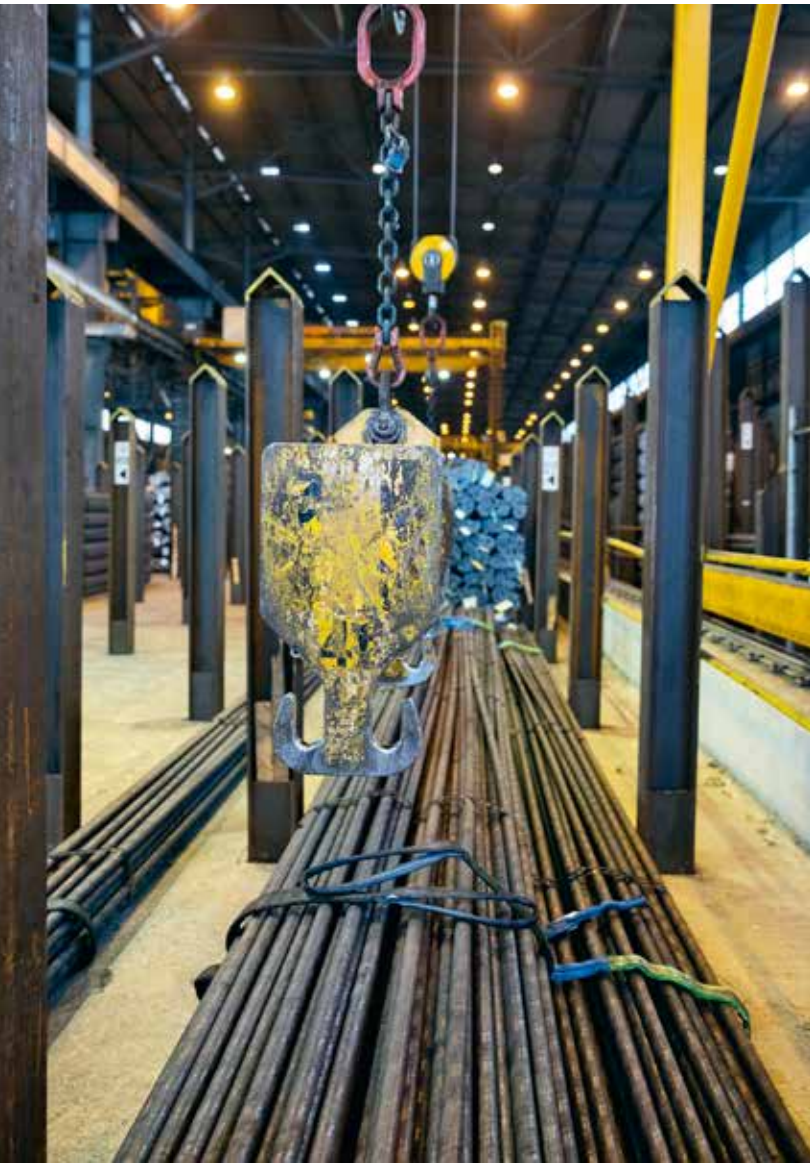
Produktionshalle der Panlog-Schwester Steeltec.
