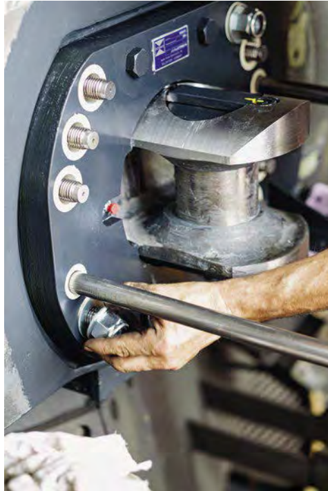
Fast geschafft: Die neue Kupplung muss nur noch fest- geschraubt werden. Rechts: Fabio Lo Piccolo, Mitarbeiter Asset Management und Transformation bei SBB Cargo.
