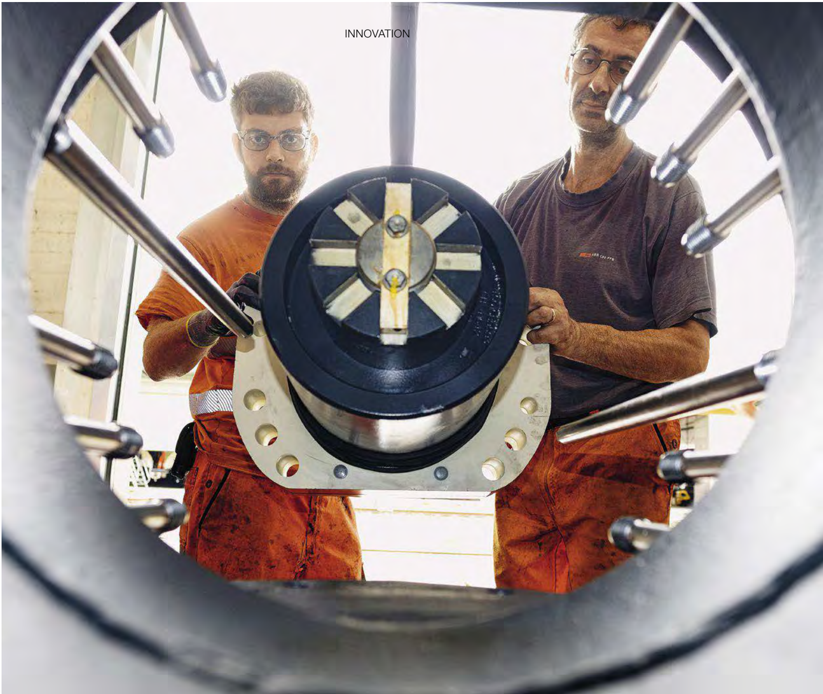
Blick aus der Lok: Zwei Werksmitarbeiter montieren die neue Hybridkupplung.
