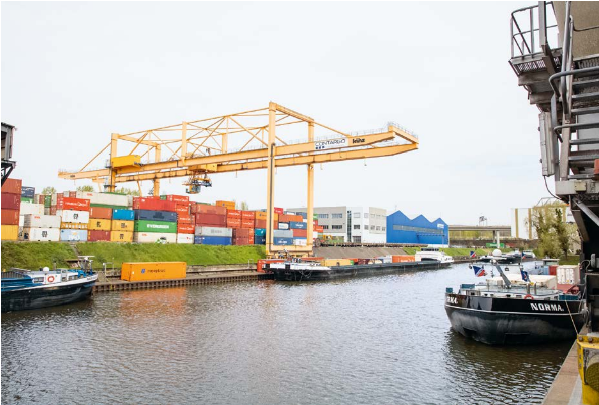
Das Hafenbecken 2 auf dem Gelände der Schweizerischen Rheinhäfen in Basel.
