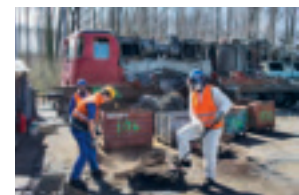
Les grandes pièces sont découpées manuellement au chalumeau en morceaux de plus en plus petits.
