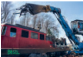
18 mars: à Ecublens, la Thévenaz-Leduc SA s'attèle à la démolition de l'Ae 6/6 «Ville de Bâle».
