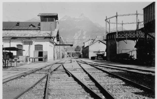
À l'époque, les rails étaient posés à la surface. Aujourd'hui, ils sont coulés dans le béton.
