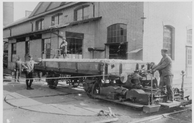
L'infrastructure en 1899: la plaque tournante était commandée manuellement.
