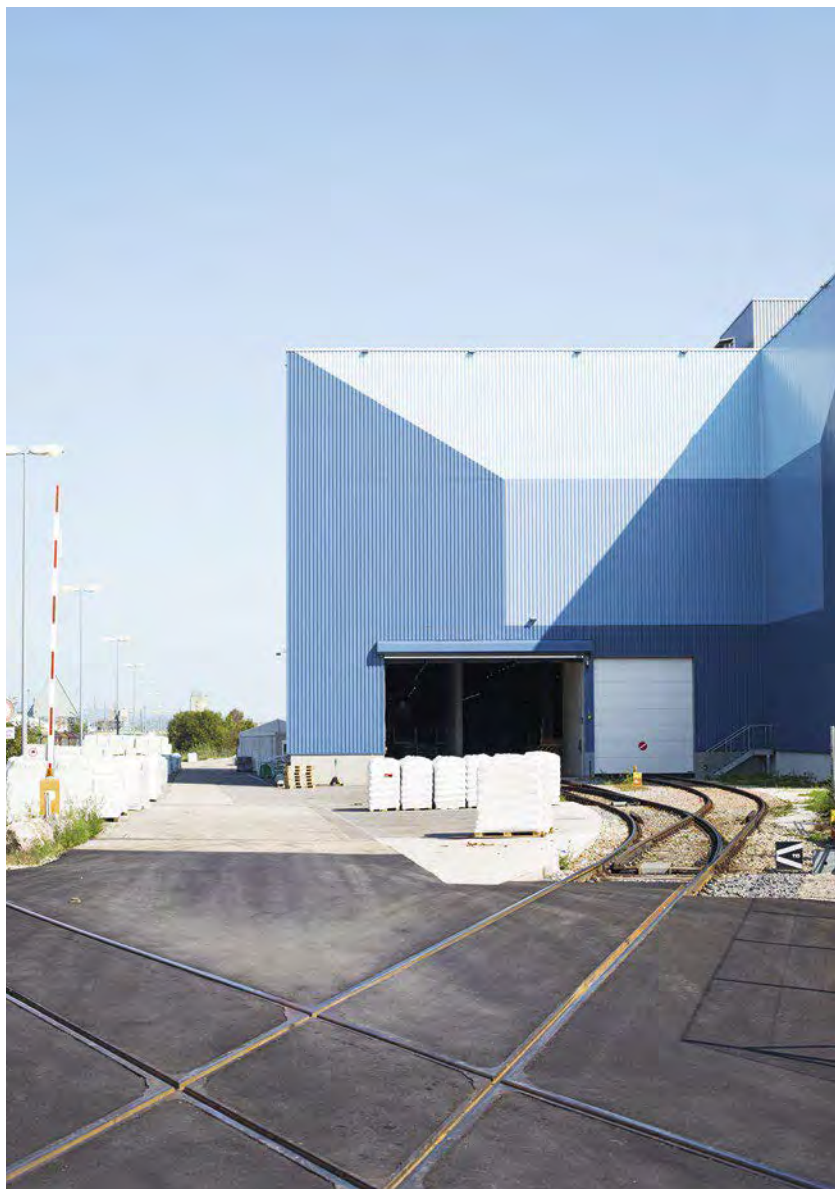
Le centre de distribution national de Migros à Neuendorf, dans le canton de Soleure.
