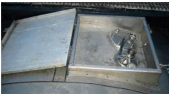
Copertura di protezione delle armature non sigillata
