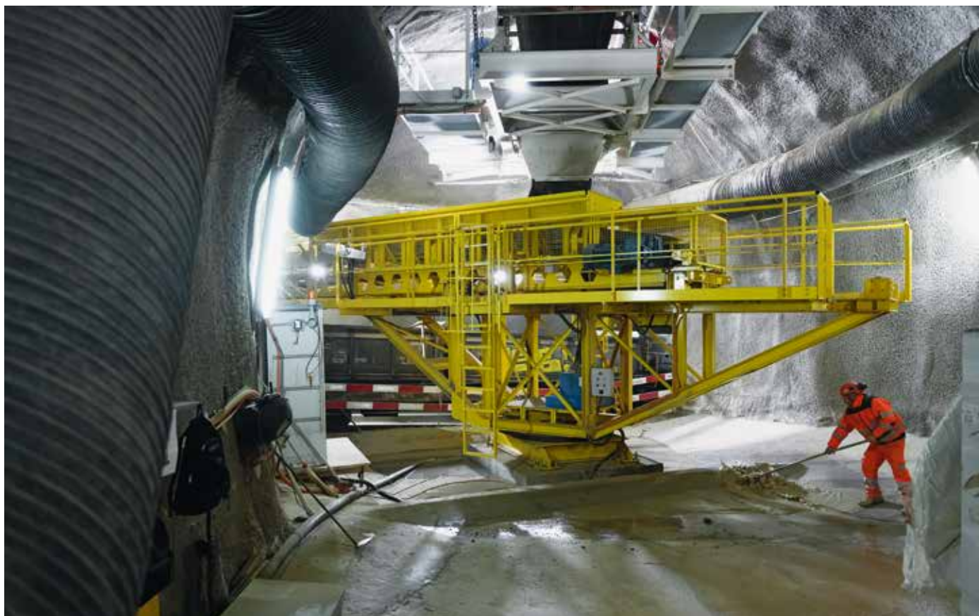
Per poter rimuovere i materiali con il trasporto su rotaia, sono state realizzate importanti infrastrutture.
