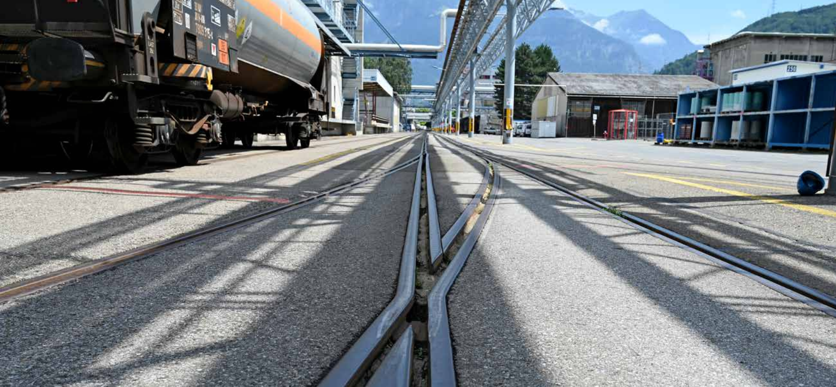
20 chilometri di rotaie attraversano un'area aziendale di 70 ettari.
