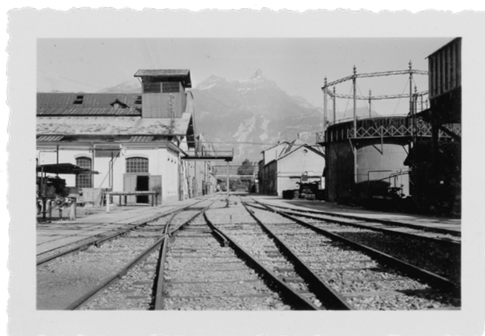
Le rotaie, che in passato erano esposte, oggi sono integrate nel calcestruzzo.
