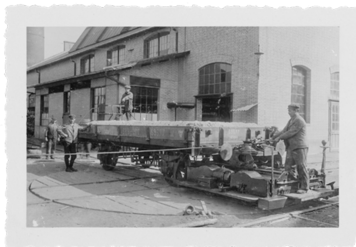
L'infrastruttura del 1899: piattaforme girevoli azionate a mano.
